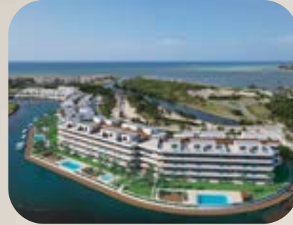
MARINA GARDEN 2 CONSTRUCCIÓN
