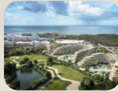
WAVE GARDEN CONSTRUCCIÓN
